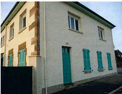
Ravalement de la façade sud-est, protection du soubassement contre l'humidité et peinture hydrofuge. Pose de volets aluminium garantissant, ainsi, un minimum d'entretien et une beaucoup plus grande longévité face aux intempéries.
