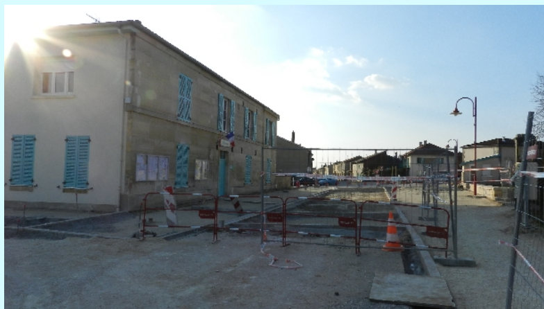
La place devant la mairie en grands travaux...
